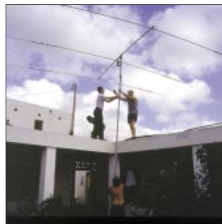
Abbau der Antennen am 14.3.
